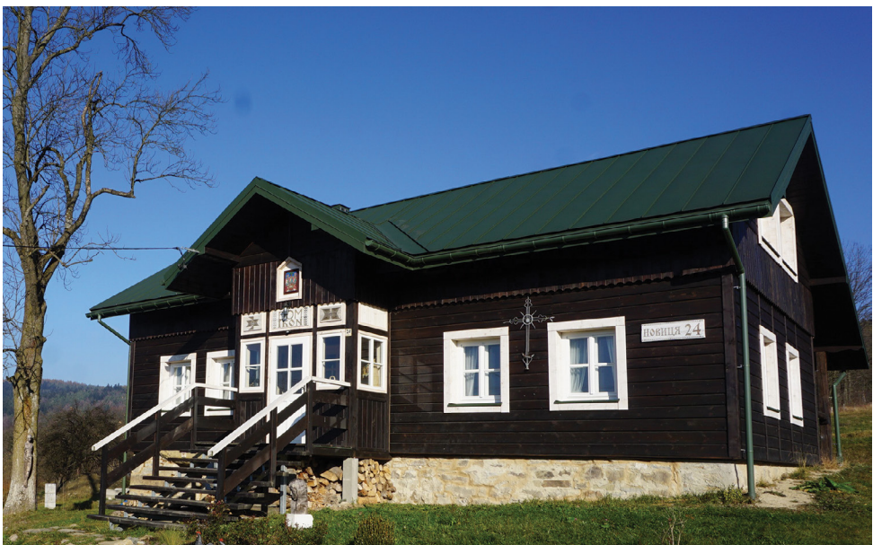
Fot. 8. „Dom Ikon”, dawna biblioteka i sklep (Nowica, stan z 2018), fot. R. Pazdur
