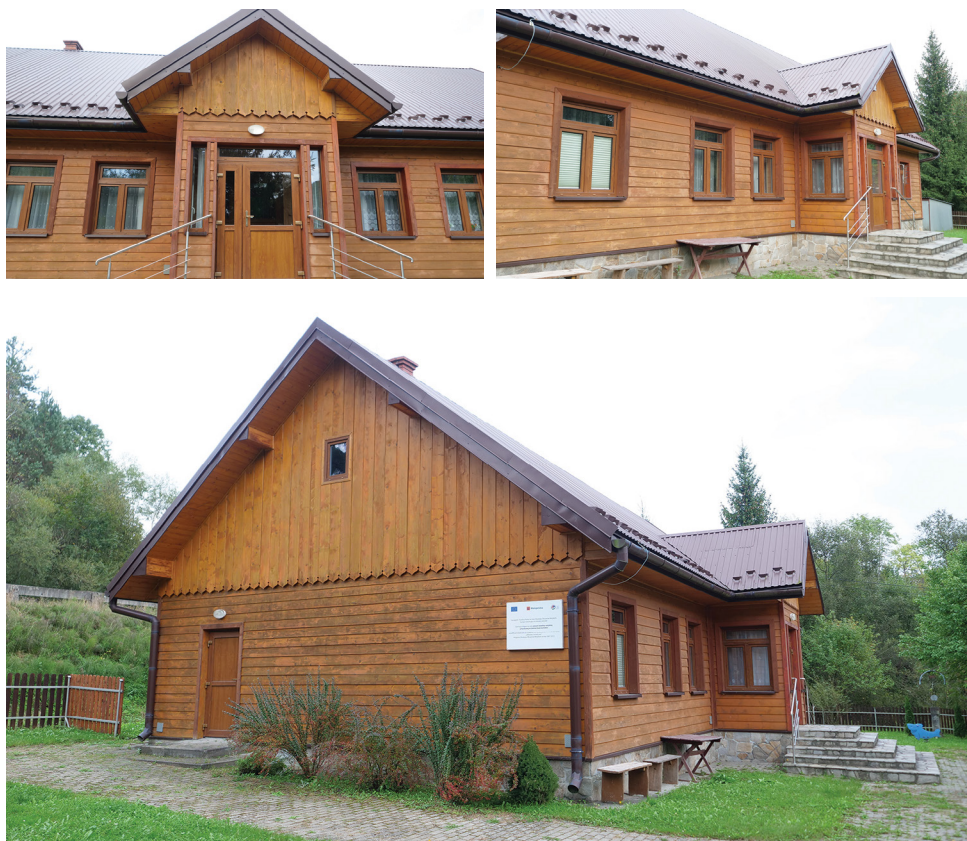
Fot. 6. Budynek dawnej szkoły w Kunkowej, dziś pełniący funkcję świetlicy wiejskiej, fot. R. Pazdur, 2023
