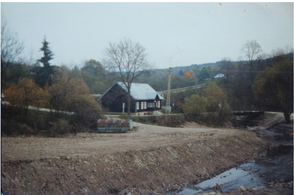
Fot. 5. Budynek szkoły w Kunkowej przed remontem, fot. nieznanym, z kolekcji Jana Dzwonczyka
